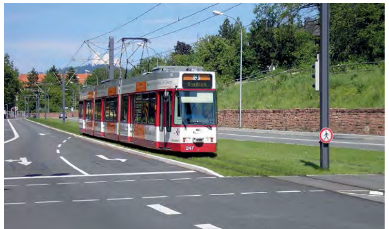
Eigener Gleiskörper als Rasengleis – die Musterlösung bei Verfügbarkeit der Flächen
