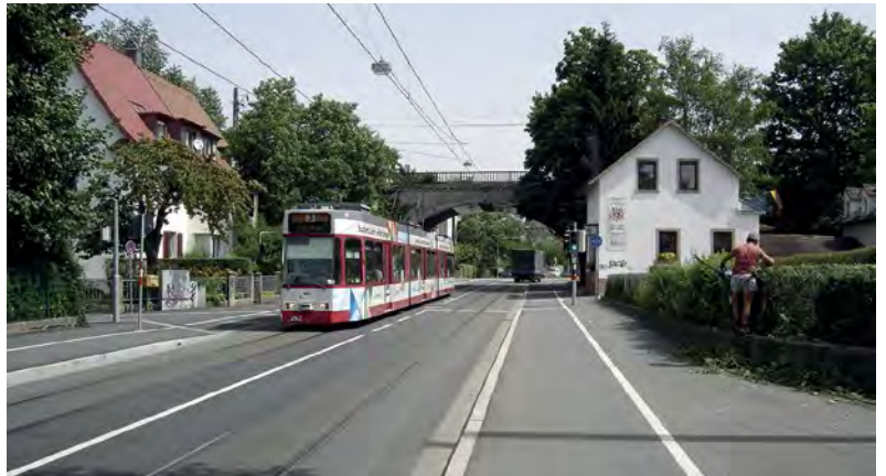
Dynamischer Gleiskörper in einer Engstelle
