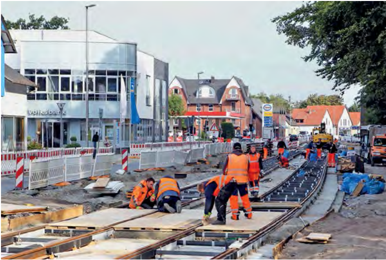
Verlängerung Linie 4 nach Lilienthal – hier die Bauarbeiten
